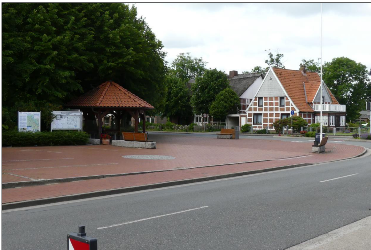
Abbildung 3: Sicht auf das Baudenkmal Nr.1 und 2 vom Betrachtungspunkt 4 (siehe Abbildung 2).
