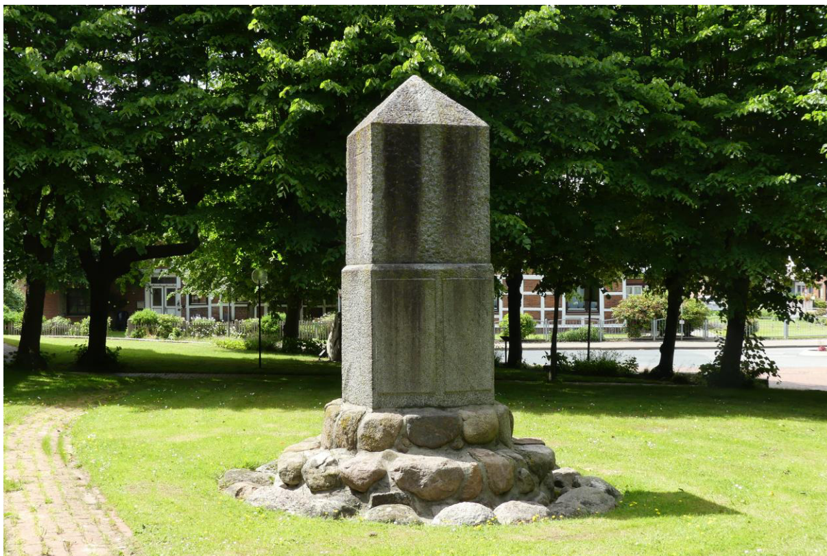
Abbildung 10: Sicht auf das Baudenkmal 4 vom Betrachtungspunkt 12 (siehe Abbildung 2).
