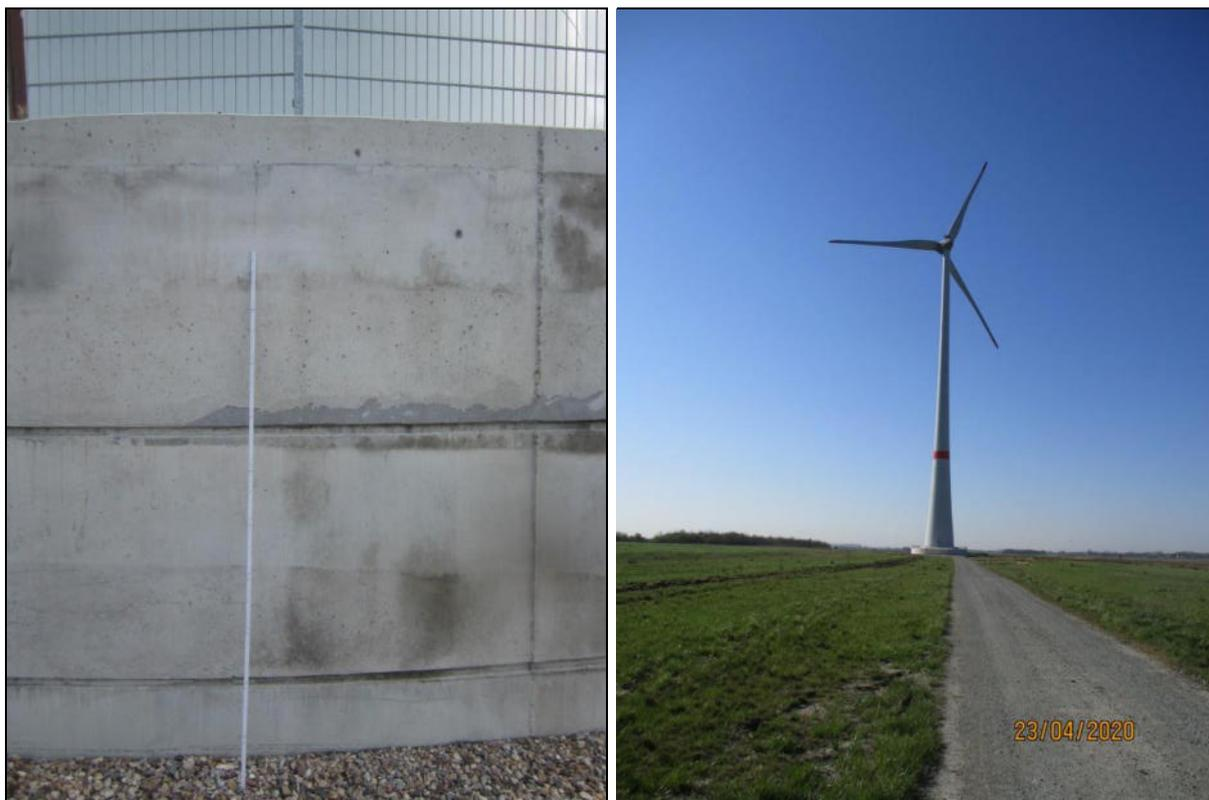
**Abbildung 26:** Das linke Foto zeigt beispielhaft eine Enercon 115 mit oberirdischem Fundament Höhe 2,50 m. Das rechte Foto zeigt die Enercon 115 aus größerer Entfernung.
