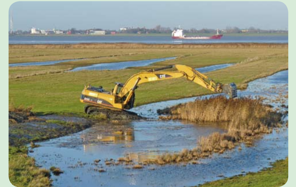
Umgestaltung einer alten Prielstruktur als breite und flache wassergefüllte Mulde.
