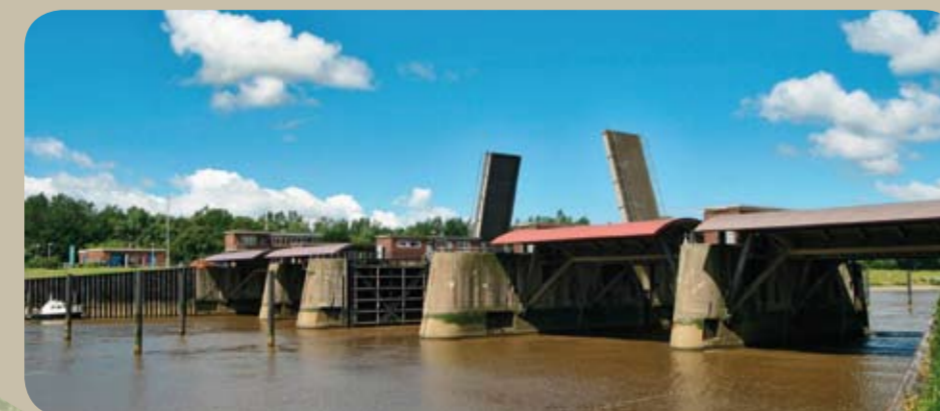
Zum Hochwasserschutz gehört auch die Abdämmung der Nebenflüsse. Wie hier an der Oste sind die Mündungen mit Sperrwerken versehen, die bei Sturmflut geschlossen werden.
