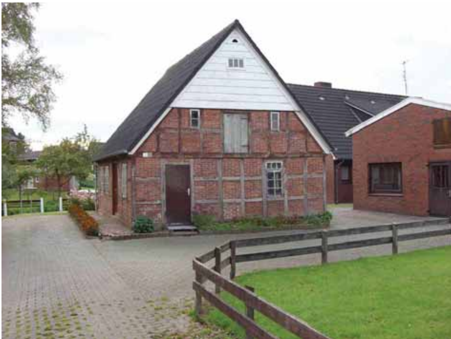
Untergenutzte Fachwerkgebäude im Kernzonenbereich - Erhaltung wünschenswert!
