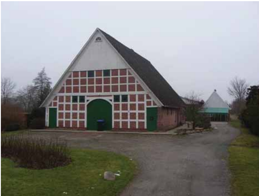
Beispiel für ein ortsbildprägendes Fachwerkgebäude in Wischhafen an der K 13
