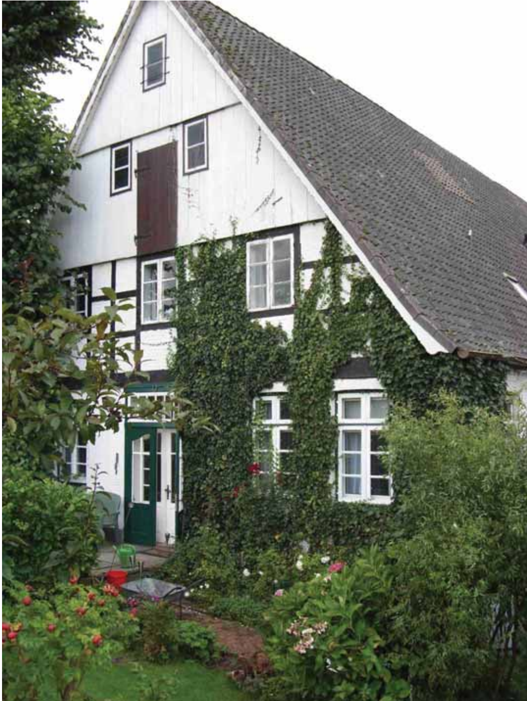
Ein sehr schönes Fachwerkhaus prägt auch den Zugang in den Hafengebiet - stattliches Fachwerkhaus neben dem Küstenschiffahrts-Museum im Zugangsbereich Hafen (siehe Seite 115 - Foto unten) Ziel: Erhalt des Gebäudes
