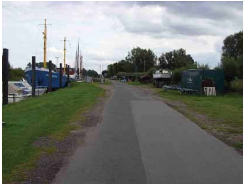
Hafenstraße - Ausbau in Naturstein-/Klinkerpflaster (unter dem Bitu liegt noch das alte Pflastermaterial!!)
