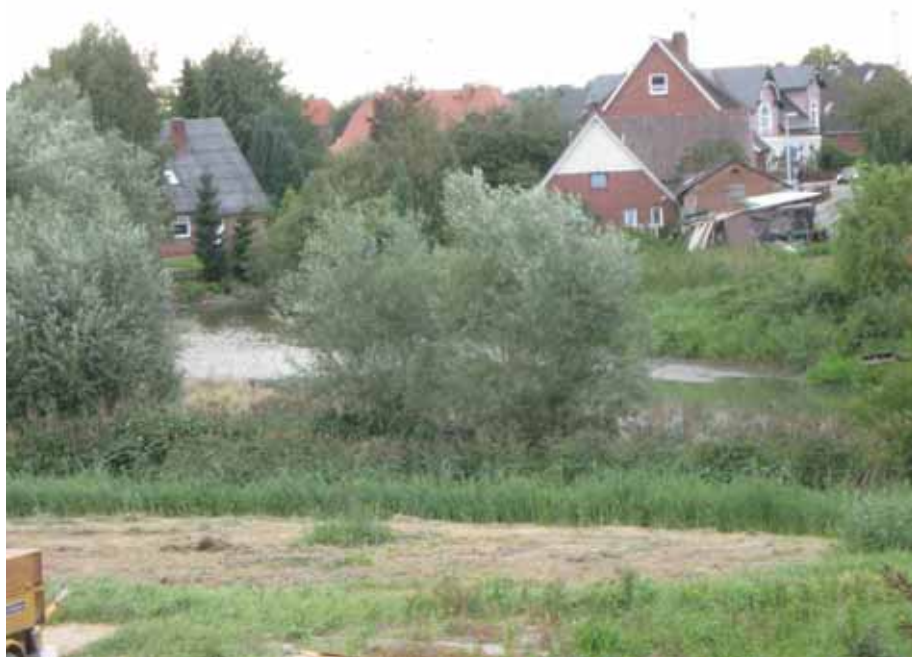
Aufwertung des Wischhafener Schleusenflethes durch Entschlammung und Gewässeraufweitungen
