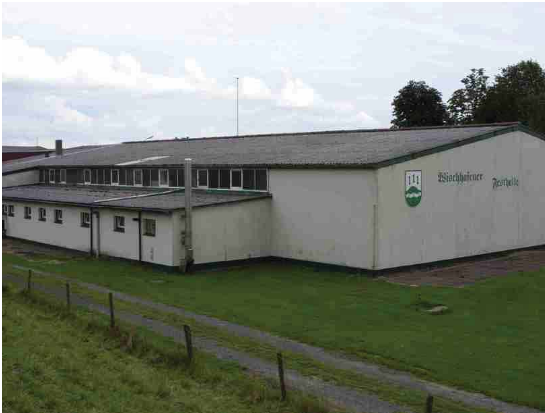
Blick auf die Wischhafener Festhalle - das Dach wurde in 2009 erneuert; die Fassade soll folgen
