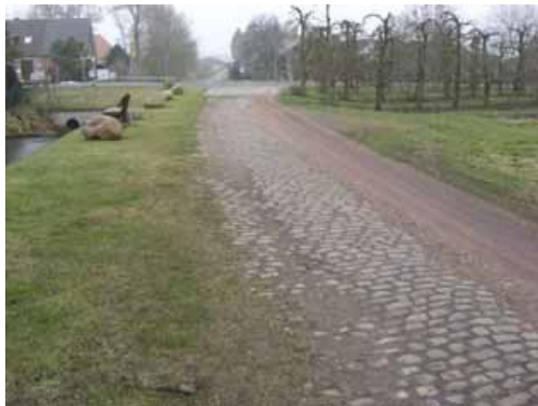
Ziegeleischleuse Neuland - Ziel: Neuverlegung /Ausbesserung der Natursteinpflasterung
