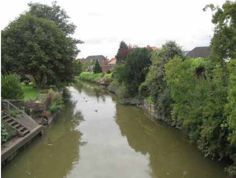
Verbaute Ufer am Wischhafener Moorkanal im Wohngebiet
