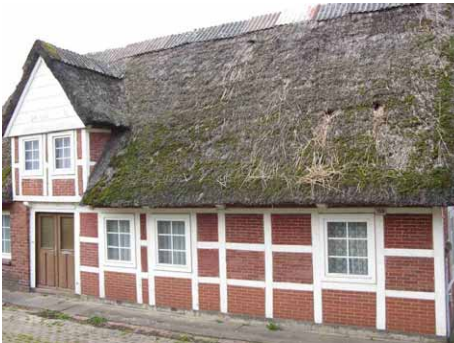
Ziel: Stilgerechte Dach- und Fassadensanierung (einschließlich Modernisierung nach Stand der Technik)
