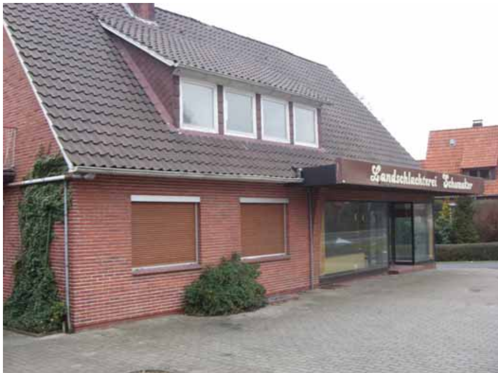
Leerstandsproblematik an der OD außerhalb des Kernzonenbereiches - Nachnutzungsoptionen sind schwierig
