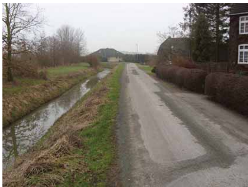
Kanalsteig Neuland - Ziel: langfristiger Ausbau als Pflasterstraße
