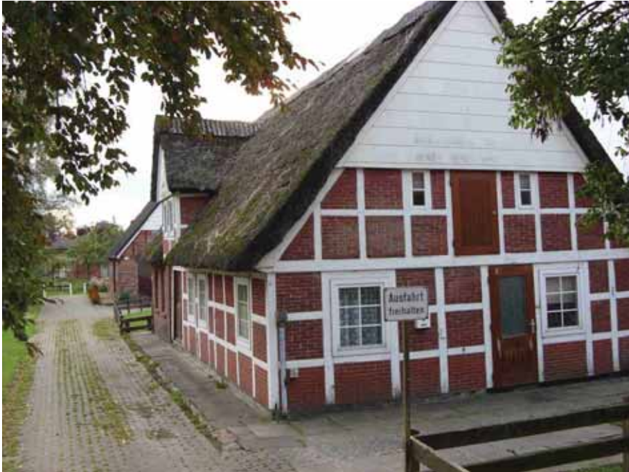
Untergenutzte Fachwerkgebäude im Kernzonenbereich - Erhaltung wünschenswert!
